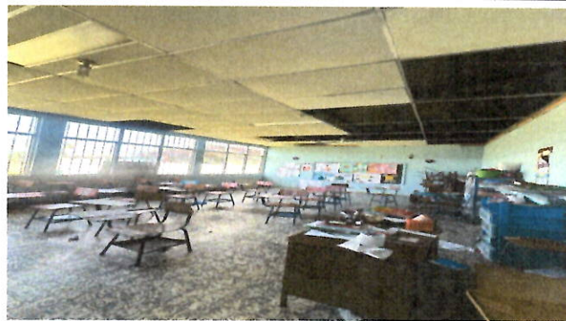
FOTO 2: ESTRUCTURA DE TECHO
