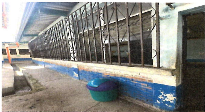
FOTO1: PINTURA EN MUROS INTERIOR Y EXTERIOR
